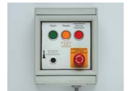
Anwahl des Stellplatzes - Aktivierung der Steuerung durch codierten Schlüssel.
