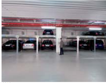
03 A Am Bedientableau wird OG-Stellplatz 114 ausgewählt. Der OG-Stellplatz 112 hebt sich nach kurzem Drücken des Startknopfes automatisch an.
